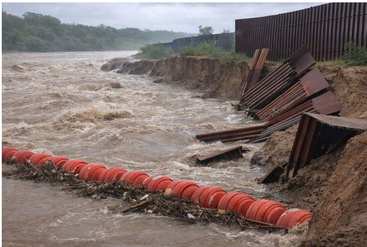
FIGURA 11: IMAGEN ILUSTRATIVA QUE MUESTRA EL COMPORTAMIENTO POTENCIAL DE UNA BOYA EN CONDICIONES DE ALTO CAUDAL EN EL RÍO GRANDE.
