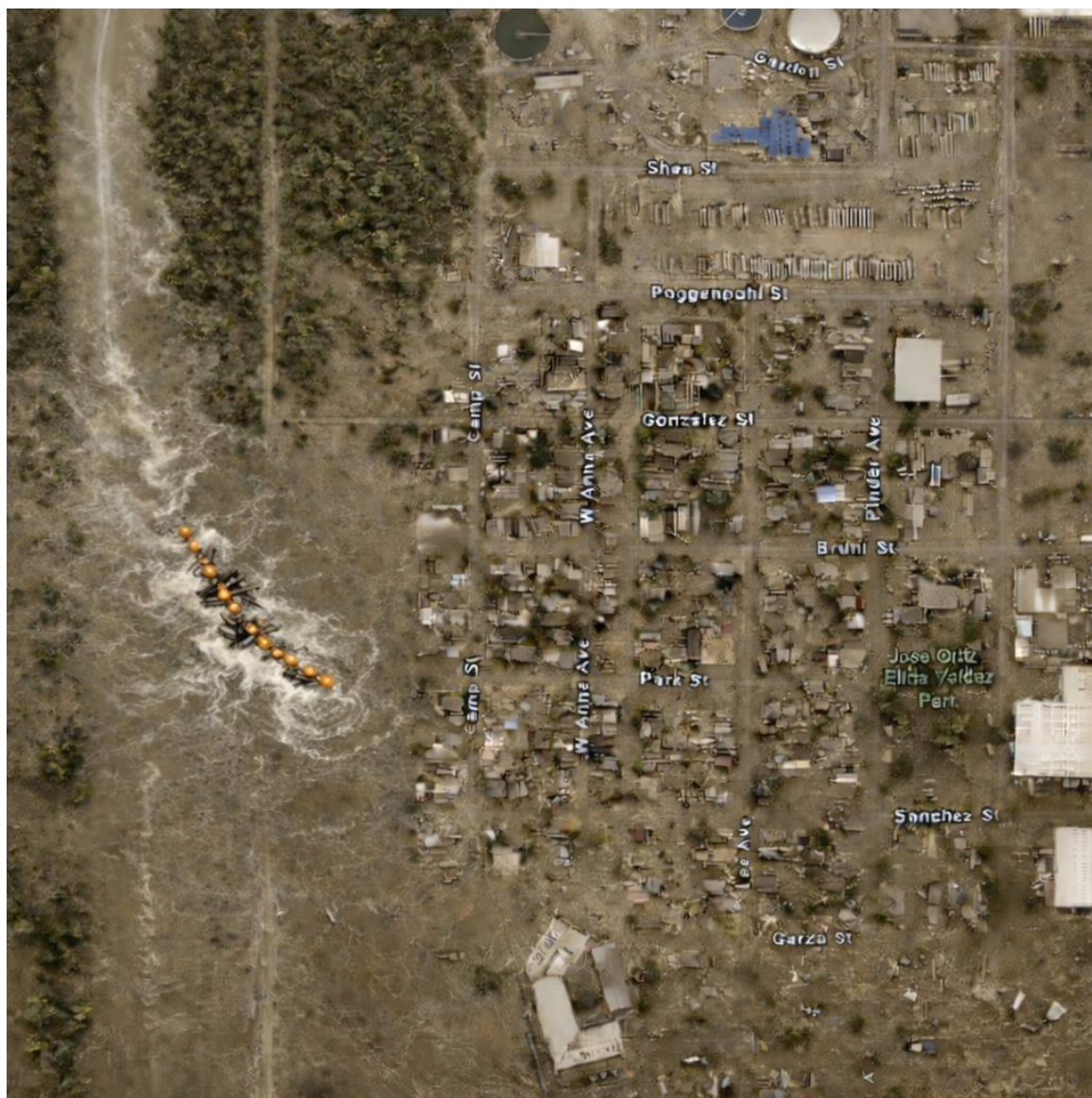
FIGURA 12: IMAGEN ILUSTRATIVA QUE MUESTRA POSIBLES INUNDACIONES EXACERBADAS POR FALLAS EN EL SISTEMA DE BOYAS BAJO CONDICIONES DE ALTO CAUDAL EN UN VECINDARIO CERCA DE LAREDO, TEXAS.
